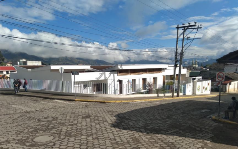
Foto 1: Intersección - vía adoquinada, parroquia Chordeleg/ Fuente: Equipo Consultor PDOT 2019-2023, 2020
